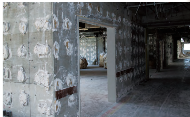
改築中の様子。前は病室でした。
